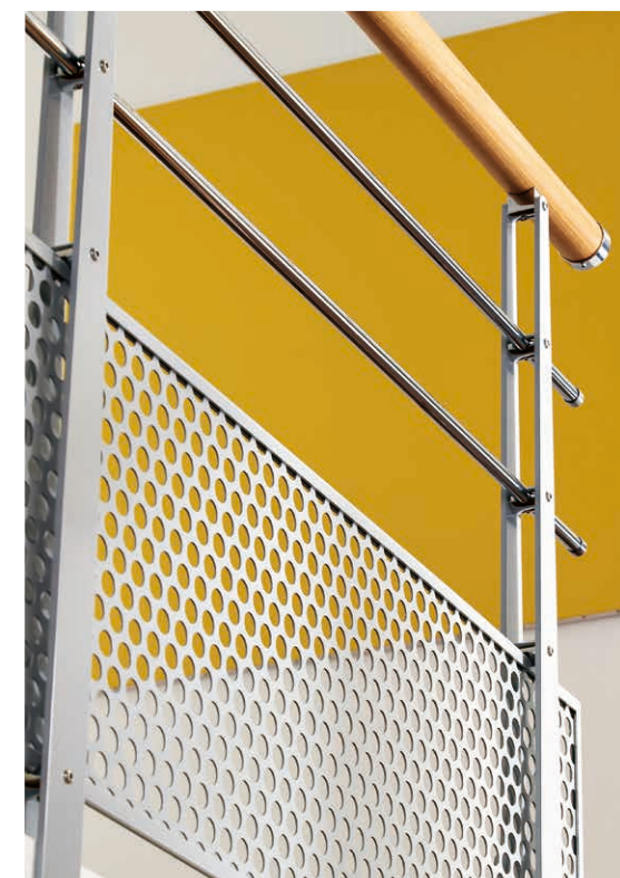
Caillebotis de la partie basse du garde-corps en acier.
