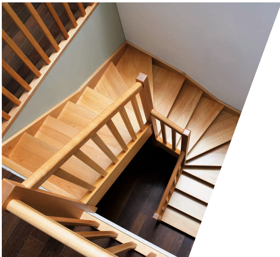
G11 - Poteaux bois de 70 mm et main courante de 52 x 70 mm profil Olive.
